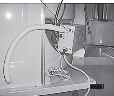
С помощью саморезов установите блок парогенератора на нижнюю деревянную закладную
